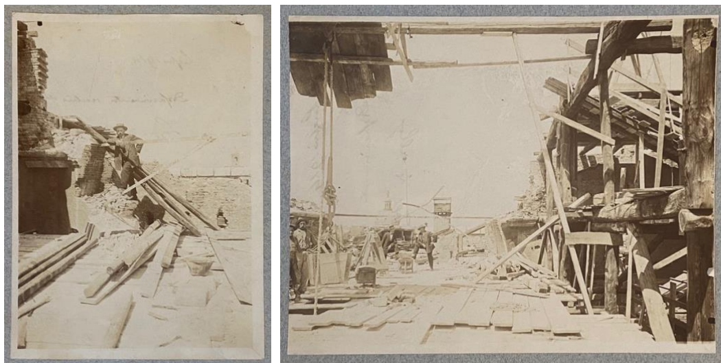
Fig. 49 Lavori di demolizione dell'attico vanvitelliano, Ingegneri o architetti posano dando le spalle al lato ovest, sullo sfondo la Torre della Pallata e la Chiesa di Santa Maria della Pace, agosto 1914, Brescia.
