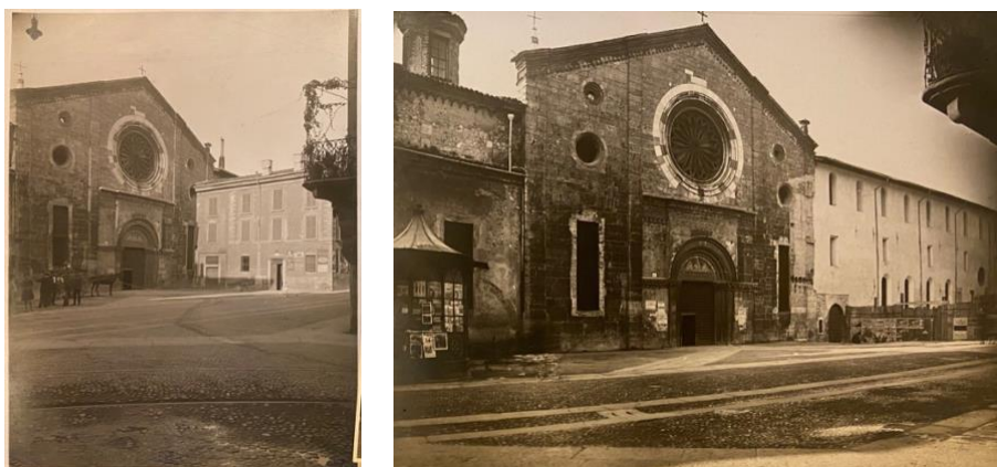
Fig. 23 Chiesa di S. Francesco, prima e dopo le opere di sbancamento per ripristinare la facciata, Brescia.
