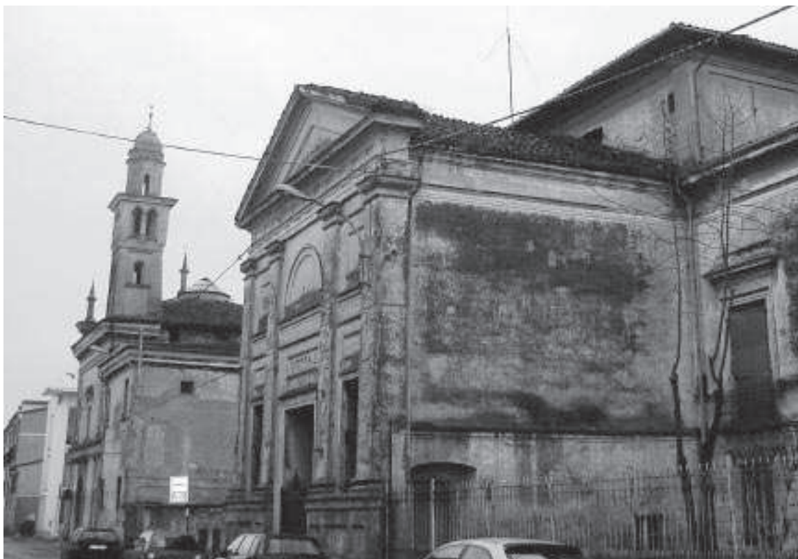
SOPRA, Casalmaggiore (CR), Ex Ospedale, con annessa chiesa di Santa Maria del Popolo.
