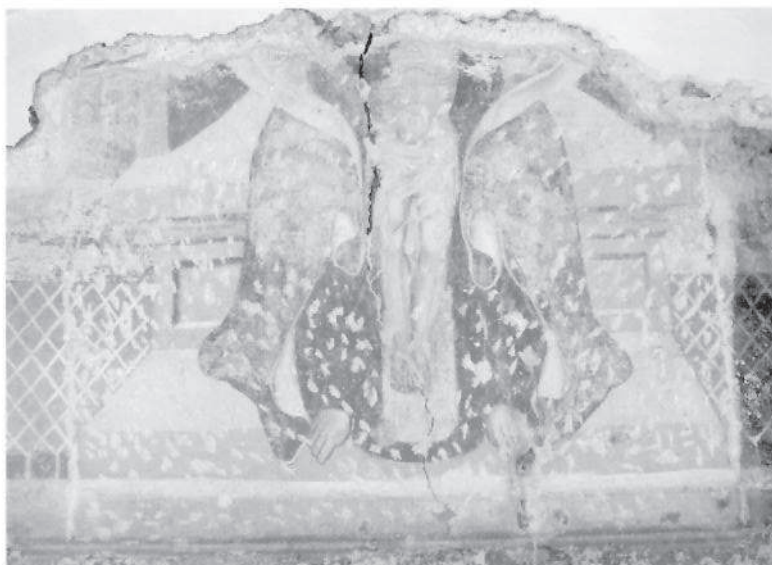
Trinità , particolare fotografato durante i lavori. Lungo il bordo destro è evidente la stesura marrone del protettivo alterato.
